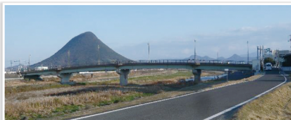
■丸亀橋(城東小学校東)
